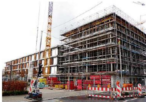
Das Oberstufenzentrum überragt das Schulhaus der Gebhardschule, es ist aber sehr kompakt geplant. Um das fünfte Geschoss gab es Diskussionen. BILD: KIRSTEN ASTOR
