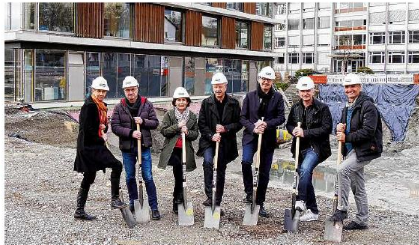
Hier entsteht ein neuer Schulbau: Über den Spatenstich für das Oberstufengebäude der Gemeinschaftsschule Gebhard freuen sich (von links): Konrektorin Charlotte Dreßen, Projektleiter Stefan Popp, vom Architekturbüro Broghammer Jana Wohlleber, Rektorin Elke Großkreutz, Architekt Werner Wohlleber, OB Uli Burchardt, Hochbauamtsleiter Thomas Stegmann und sein Stellvertreter Ralph Bothe. BILD: KIRSTEN ASTOR
